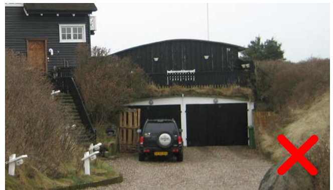
Det fritlagte kælderareal er for bredt, der er 2 garageporte og indkørslen for bred.
