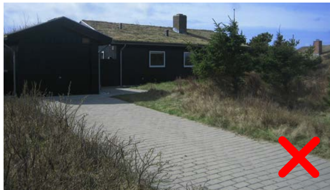
Indkørsel med fast belægning er ikke ønskeligt.
