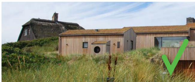
Varmepumpe godt integreret med boks på facaden.
